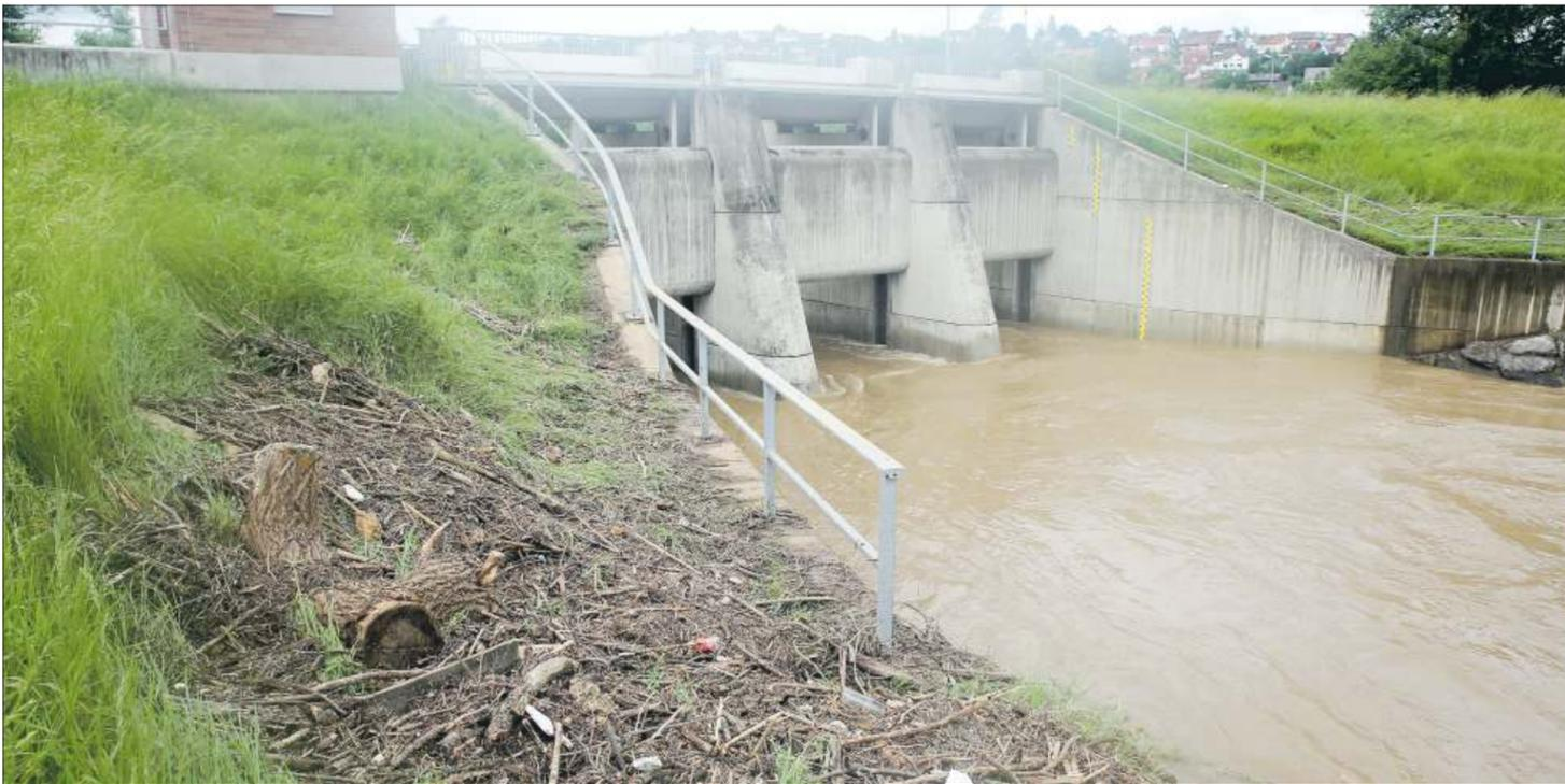
Mit Hilfe eines massiven Sperrwerks im Damm kann Hochwasser aus der Rems in einem normalerweise trockenen Erdbecken zwischen Gmünd und Lorch gepuffert werden. Wassermassen, die früher in Lorch und Waldhausen regelmäßig über die Ufer traten und hohe Schäden verursachten, können dadurch kontrolliert abfließen. Dieses Konzept hat sich erneut bewährt. Fotos: edk
