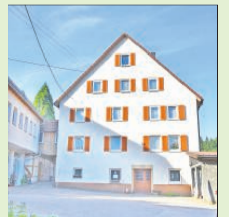
Die Ulrichsmühle war die „Keimzelle“ für die Ortschaft Höning. Die ursprünglichen Gebäude fielen allerdings 1812 mitsamt ihren Bewohnern einem Brand zum Opfer. Foto: gbr
