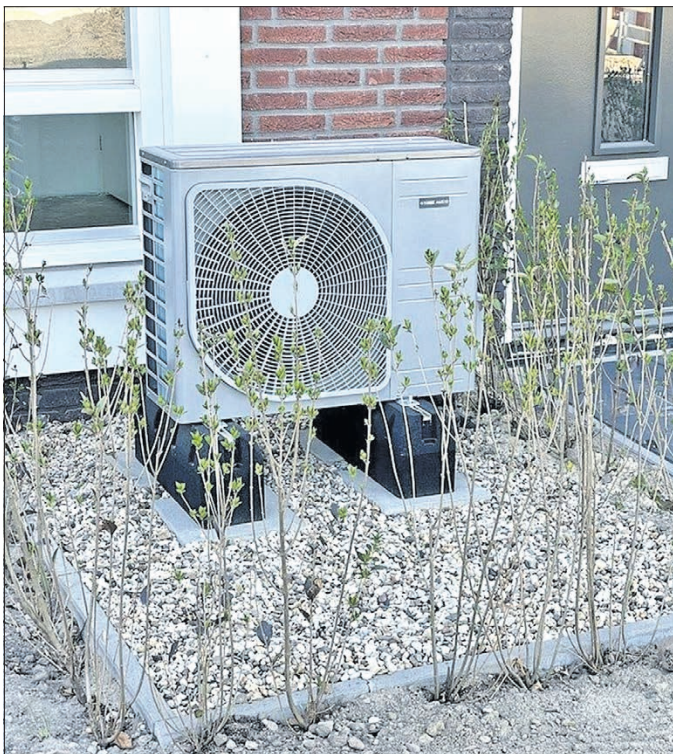
Eine Wärmepumpenheizung nutzt die Wärme aus der Umgebung zum Heizen.
