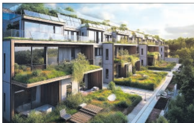
Bei PV-Anlagen auf Dächern setzt sich immer mehr das Umkehrdach durch, es bietet viele Vorteile. Foto: DJD/FPX/Dar1930 - stock.adobe.com
