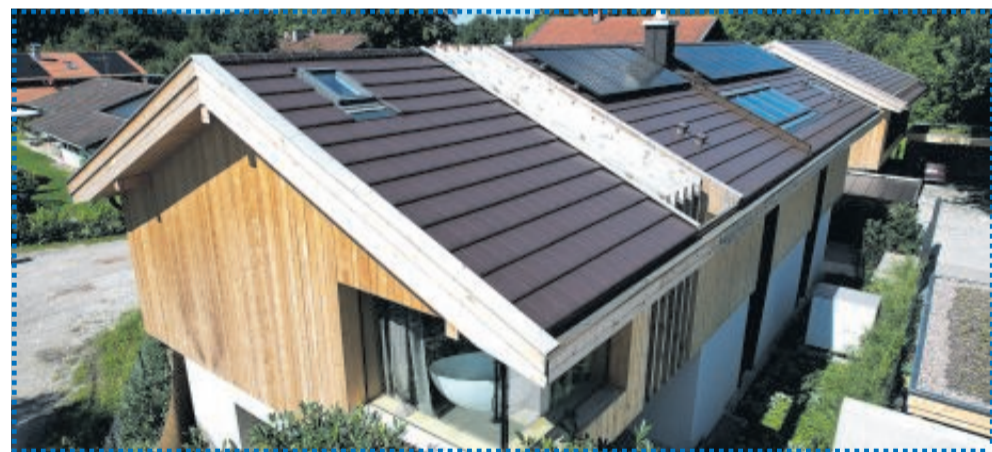
Von hybrider Wärmeerzeugung spricht man, wenn die Wärmepumpe etwa mit Fotovoltaik und/oder einer Holzfeuerstätte kombiniert wird. Foto: DJD/BDH/Erlus
