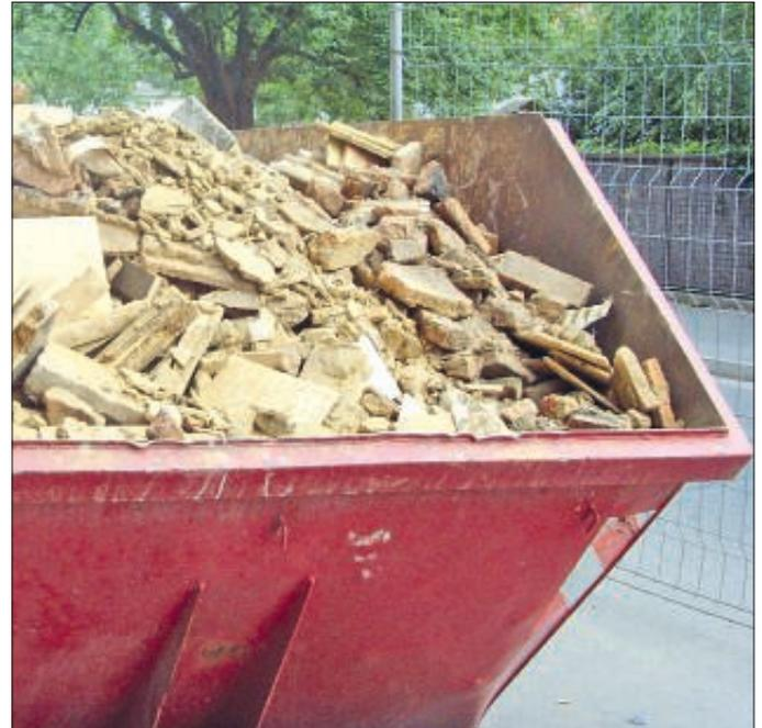
Ein sogenannter Absetzcontainer. Diese Behälter werden von einem Lastwagen an der gewünschten Stelle abgesetzt. Sie sind in verschiedenen Größen verfügbar, aber in der Regel kleiner als Abrollcontainer.
