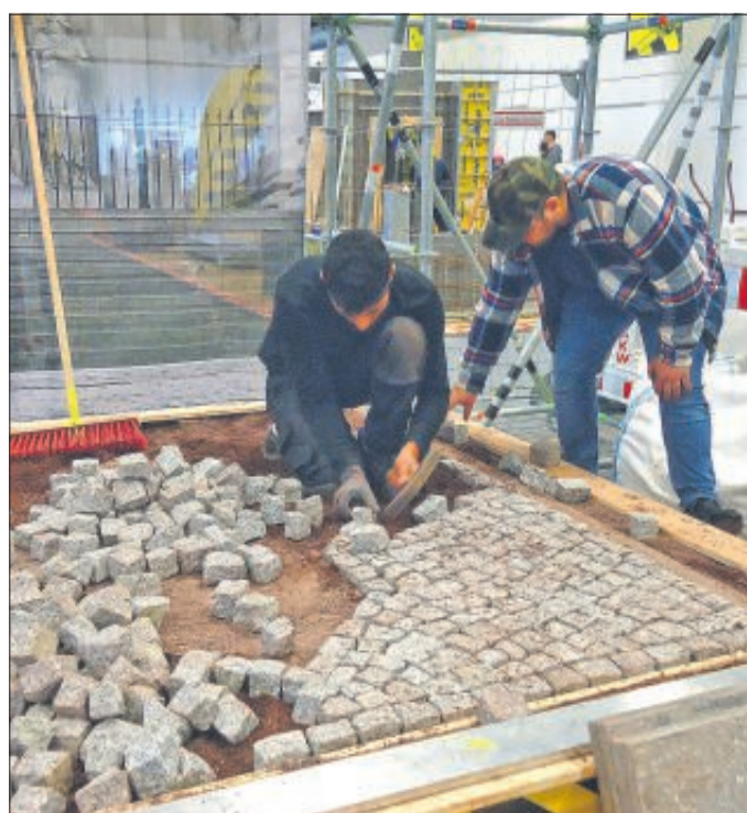
Baumesse: Pflastersteine verlegen Foto: Busche
